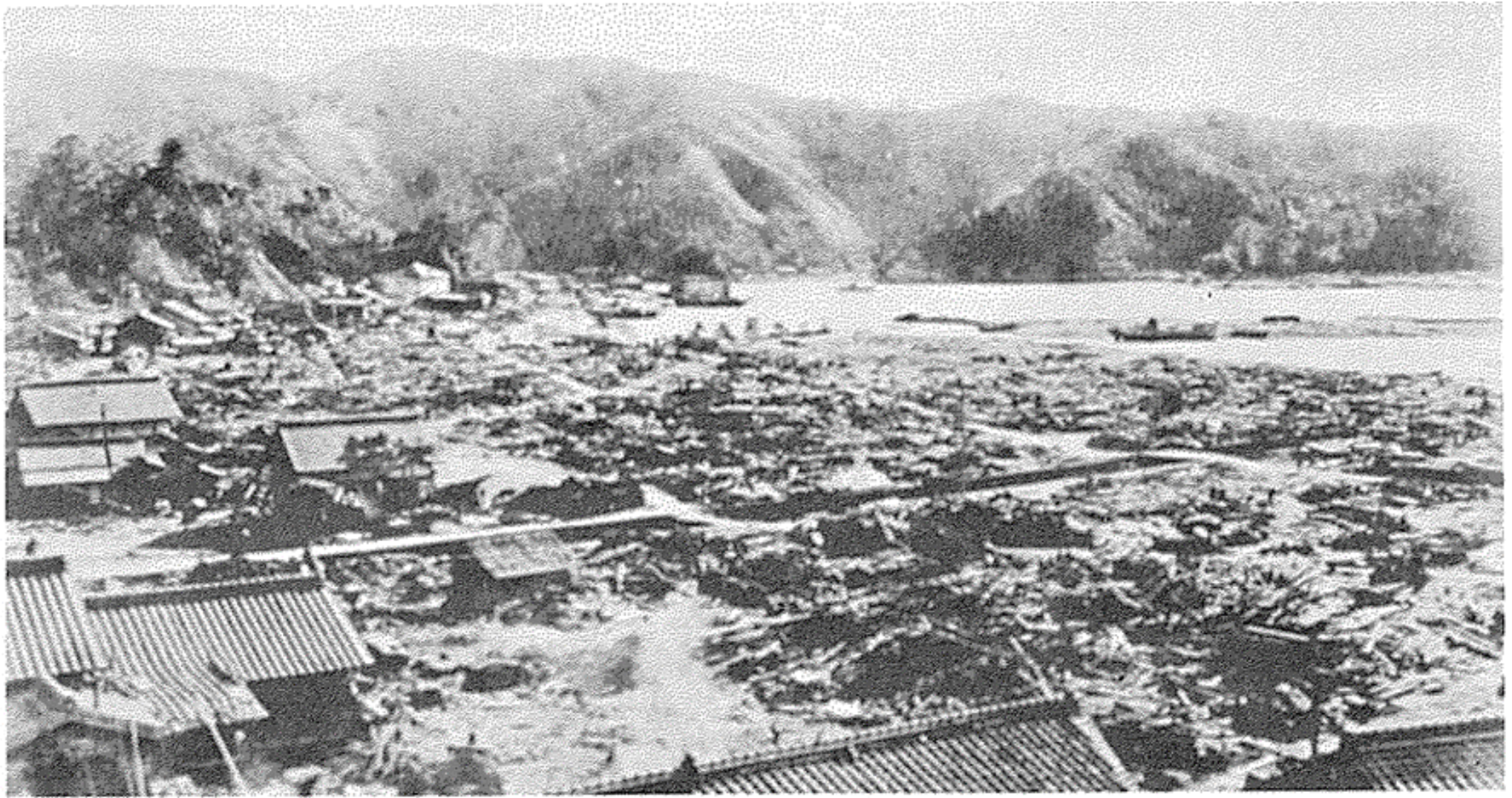
↑ 津波により全滅した錦町
