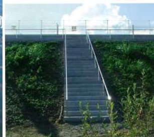
震災後につくられた津波一時避難場所
